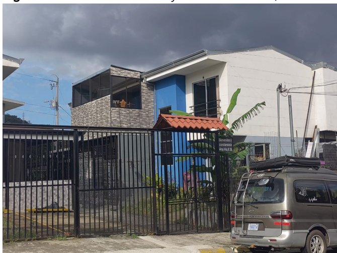
Figura 1. Cerramiento externo y fachada adicional, Condominios Las Anas
