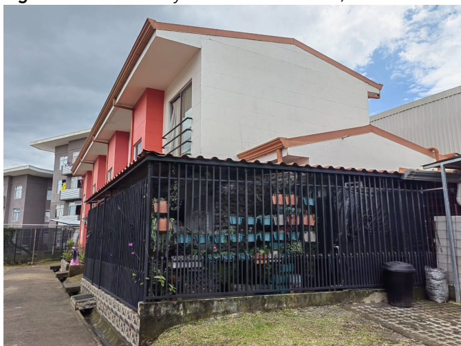
Figura 2. Cerramiento y construcción exterior, Condominios Las Anas
