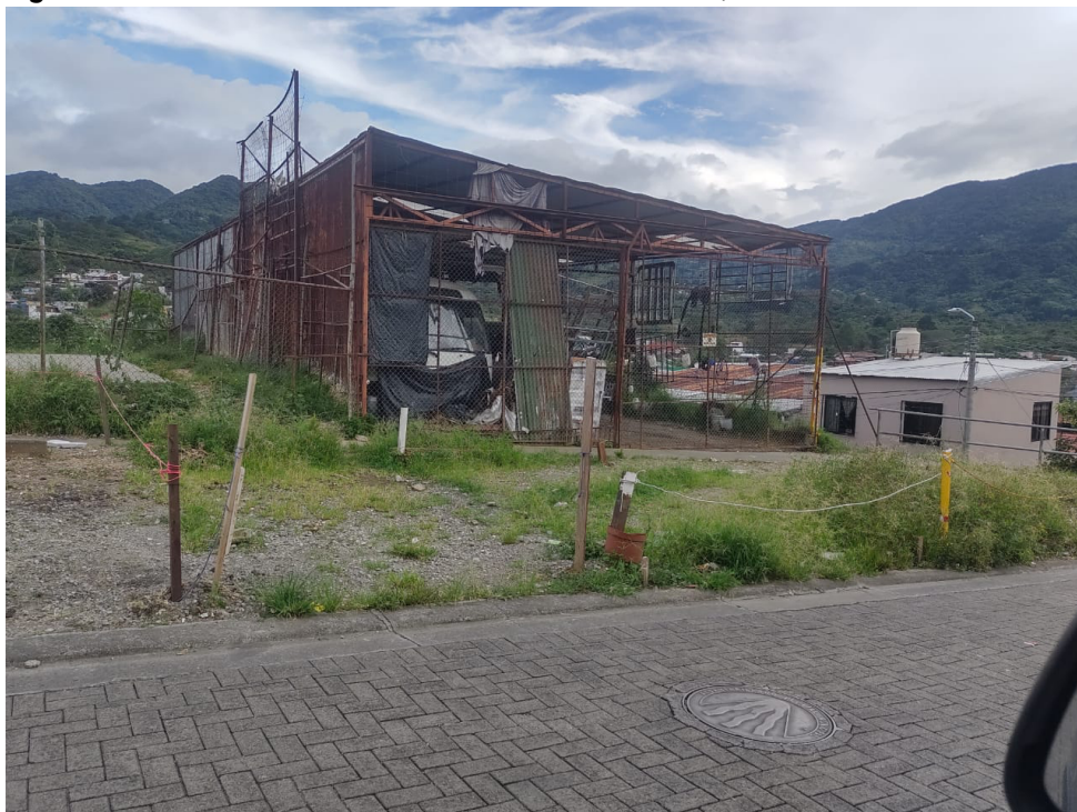
Figura 3. Áreas comunes con construcciones no autorizadas, Condominio Las Mandarinas
