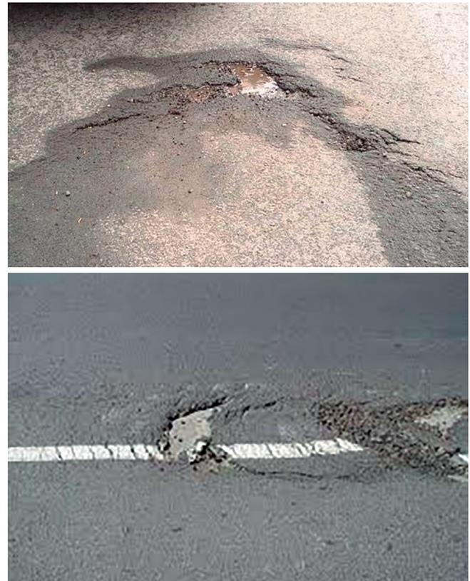
Figura 3a y 3b. Falla por mala adherencia entre capas.
