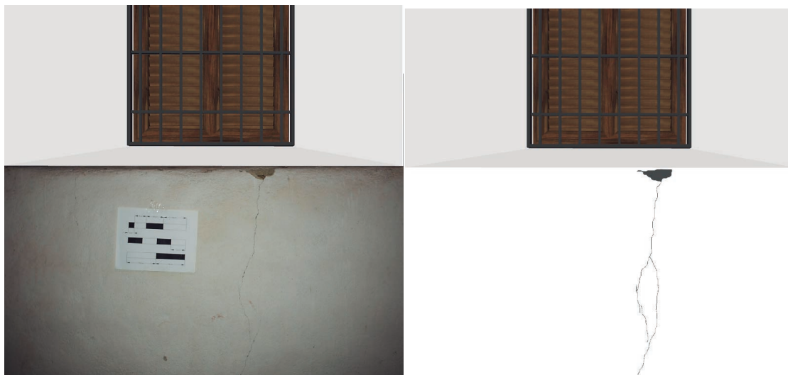
Fig 5. Comparación entre la degradación observada y su representación en el modelo tridimensional
