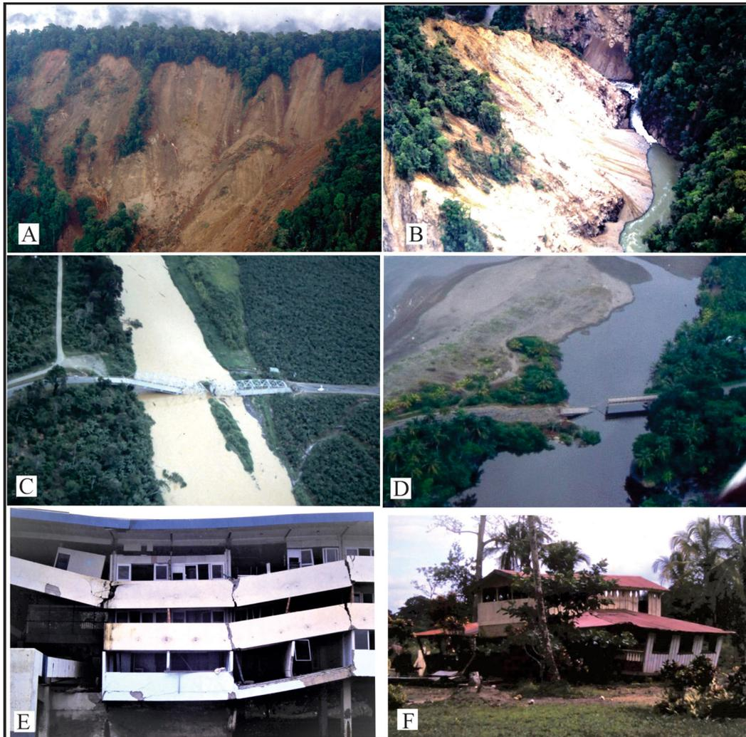
Fig. 4: (A) Deslizamientos en la cuenca media del río Chirripó. (B) Cauce ligeramente represado por deslizamiento en la margen izquierda del río Chirripó. (C) Puente caído sobre el río Estrella. (D) Losa caída del puente sobre la quebrada Westfalia, al sureste de la localidad de Westfalia. (E) Daños estructurales en el Hotel Las Olas cimentado sobre arrecife coralino levantado. (F) Casa con las paredes inclinadas en el camino a Westfalia. Fotos Walter Montero.
